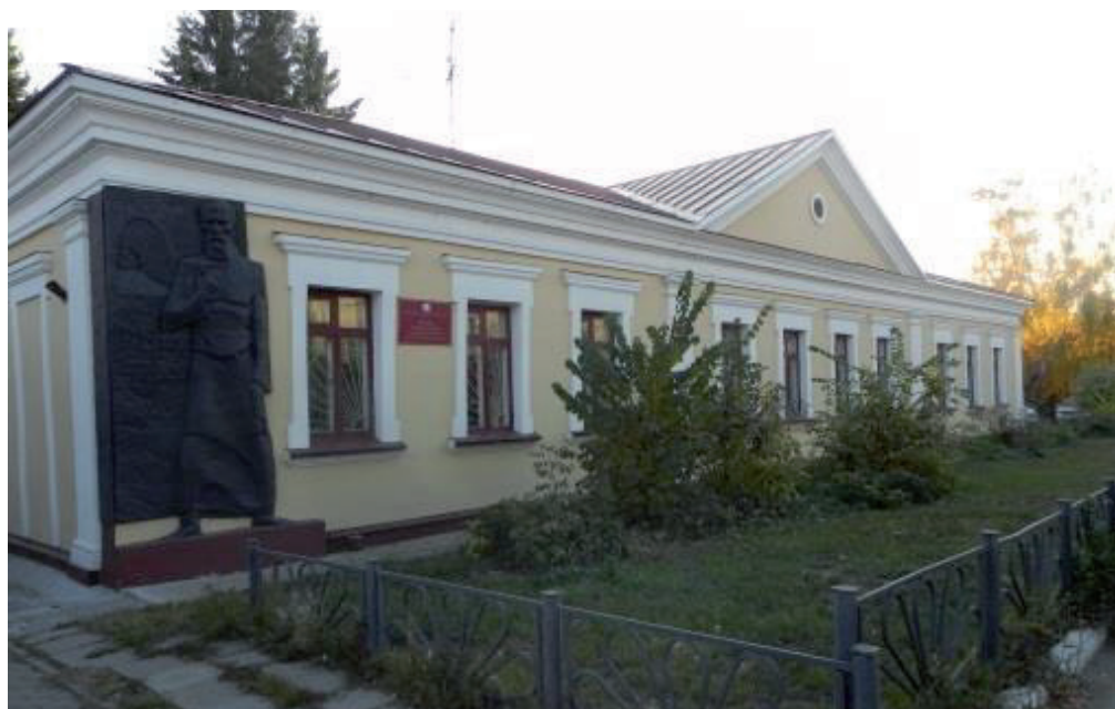
Илл. 26–27. «Комендантский дом» в Омской крепости (вид до (2021) и после последней реставрации) Fig. 26–27. “The Commandant’s House” of the Omsk fortress (view until (2021) and after the last restoration)
