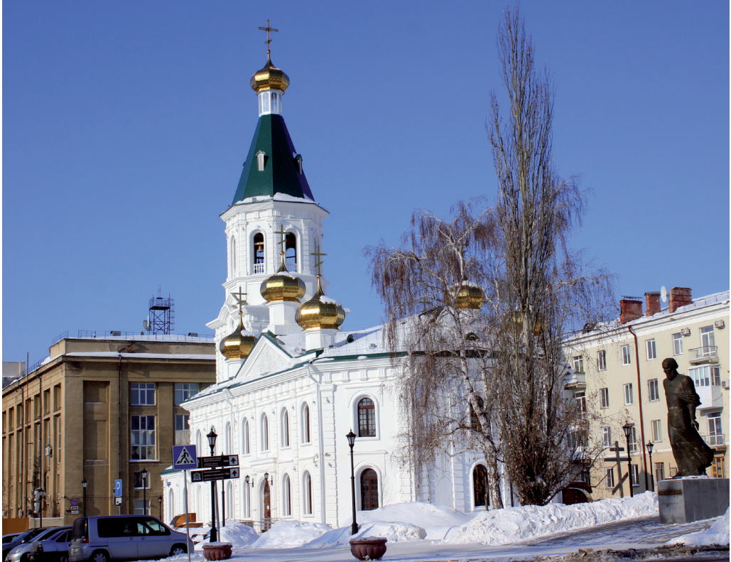
Илл. 42. Воскресенский собор в Омске после реконструкции (2024)
